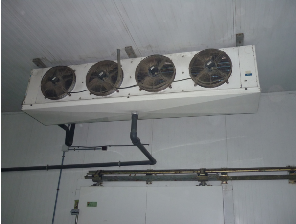
Ilustración 17. Detalle interior de cámaras
